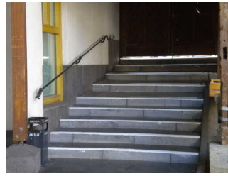
Treppe in den Innenhof
