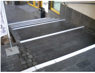
Treppe in den Innenhof
